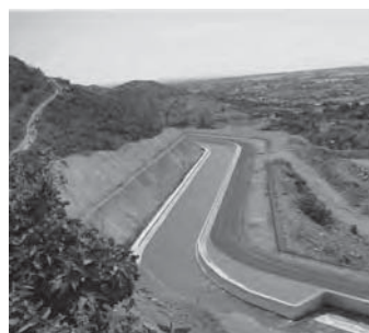
ソンドウ・ミリウ発電所から つながる放水路（504m）
