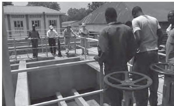
写真② 南スーダン国ジュバ市浄水場維持管理指導
