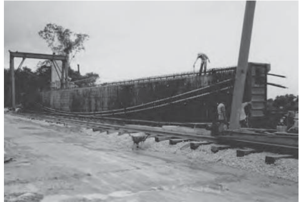
ケラントラン川のタナメラというところに、680mのPC橋梁を建設しました。桁高が2.5m、桁の長さは50mもあり、当時のPC桁としては最大規模だったと思います。1995年12月撮影。
