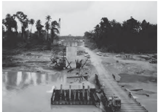
ケラントラン橋の下部工事状況。下部工に使用するコンクリート杭も現場で製作しました。1995年12月撮影。
